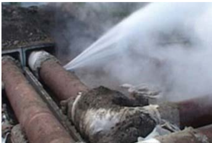
Мал. 53. Порив на водопровідній мережі
