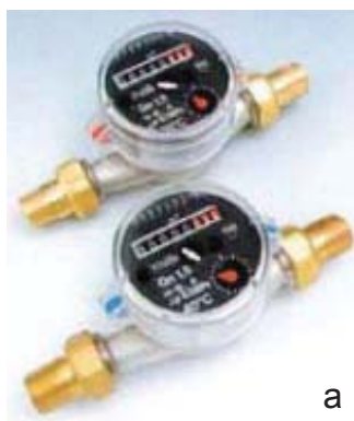
Мал. 65. Лічильники води а) квартирні б) будинковий
