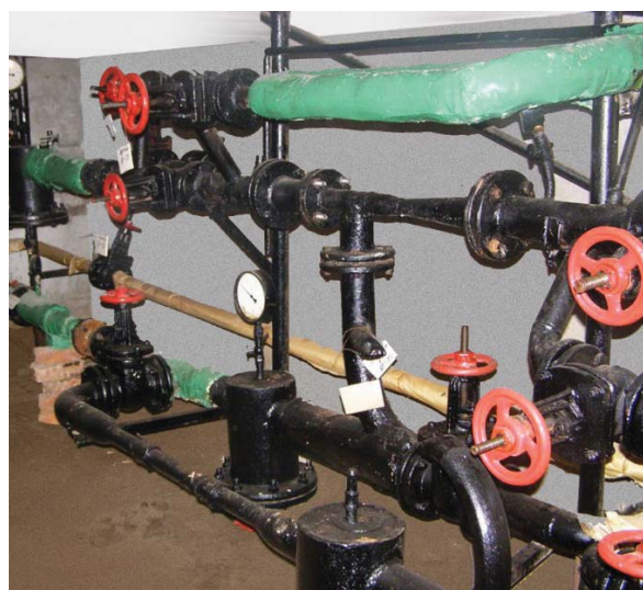
Мал. 26. Інженерні комунікації у підвалі будинку
