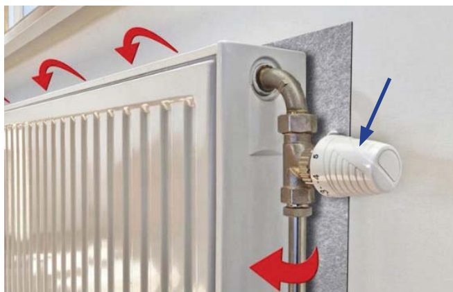
Мал. 79. Тепловідбивний екран та терморегулятор на батареї
