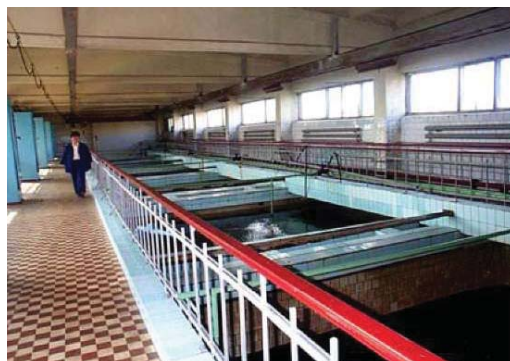
Рисунок 5.5 Водопровідні очисні споруди
