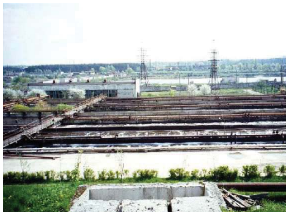
Рисунок 5.9 Каналізаційні очисні споруди
