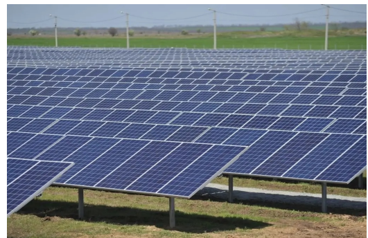
Рисунок 6.8 СЕС Токмак Solar Energy (Запорізька обл.)
